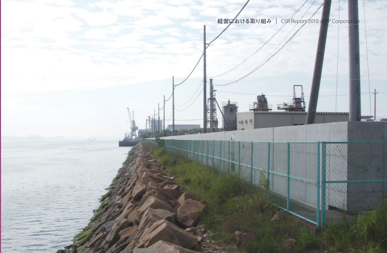
福山市箕沖町の福山工場、福山リサイクル工場、福山配送センター、福山ピッキングセンターの約18万㎡にも及ぶ敷地は海に面しているため、高波や津波の対策として高さ約2mの壁を3方に設置しています。
