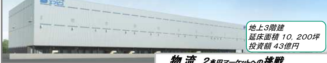
福山クロストックセンター '14/7 倉庫、'14/11 ソーター稼働予定
