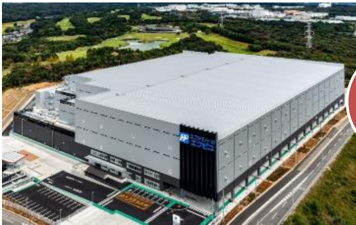
関西工場・関西ハブセンター
